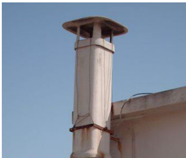
- Figura 3: Canna fumaria in cemento amianto -
