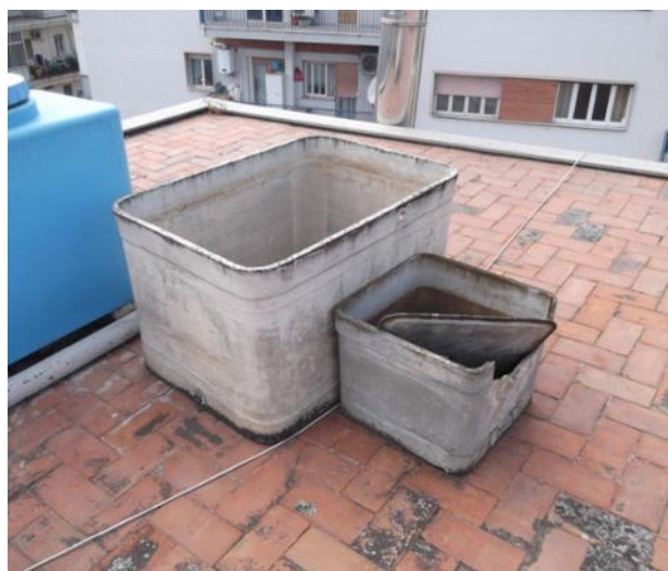
- Figura 4: Serbatoi in cemento amianto -
