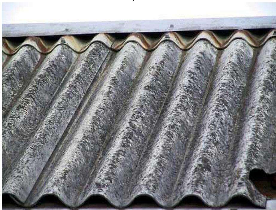
- Figura 2: Copertura in cemento amianto -
